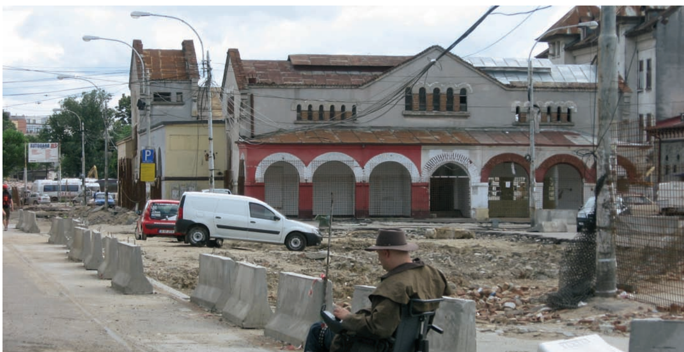
Strada Berzei în șantier, iulie 2011
