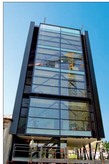
Premiul Secțiunii Arhitectură la Anuala de Arhitectură 2007 - Imobil birouri strada Mihai Eminescu, arh. Pavel Bogdan Babici, arh. Lucian Simion
