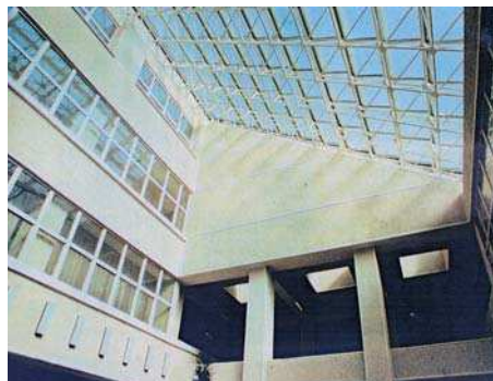
Sediul IELIF Vaslui, vedere exterior, interior, plan parter
