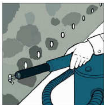
Fig. 3 - Curățarea orificiilor prin care se va efectua injectarea
