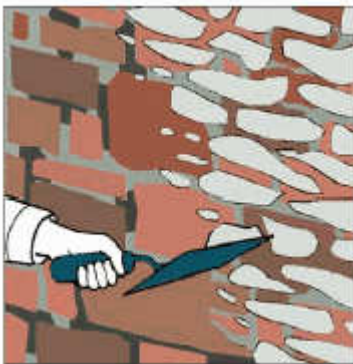
Fig. 8 - Aplicarea mortarului ce asigură aderența tencuiei finale
