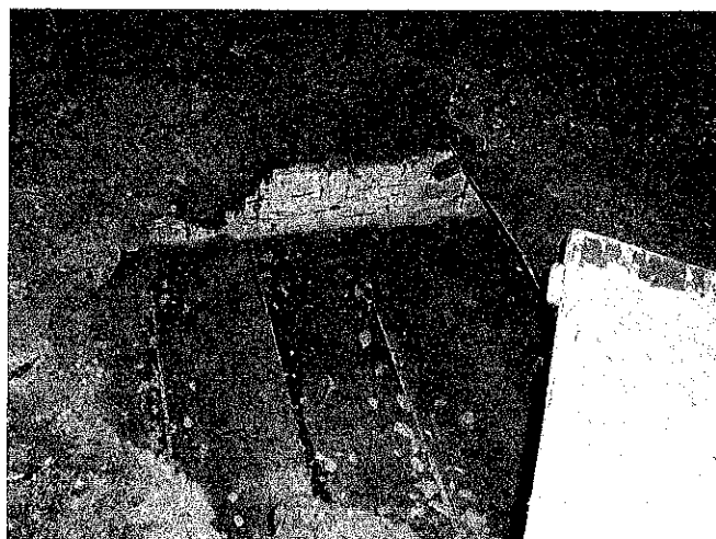
Foto 23 – Detaliu planșeu de pod cu grinzi din lemn
