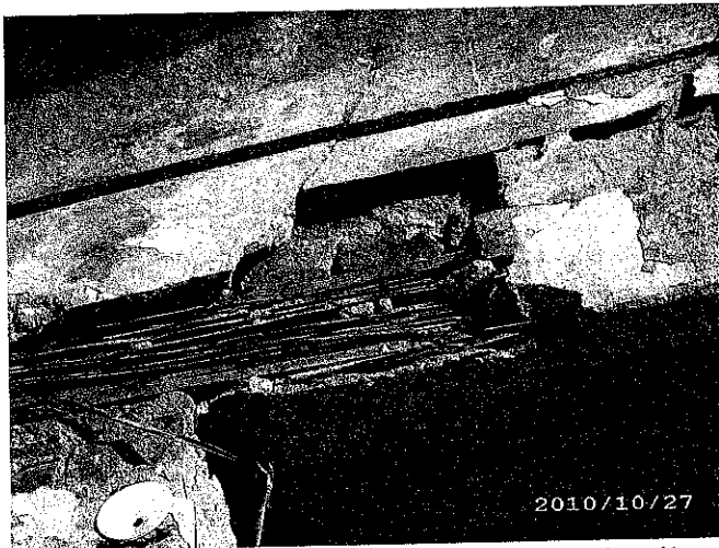
Foto 43 – Degradarea tencuielii și buiandrugilor din fațada principală
