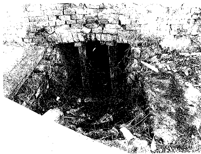
Foto 52 – Degradarea zidăriei la intrarea în subsolul clădirii
