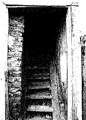
Foto 21 – Vedere scară de acces în pod – corp lateral stânga
