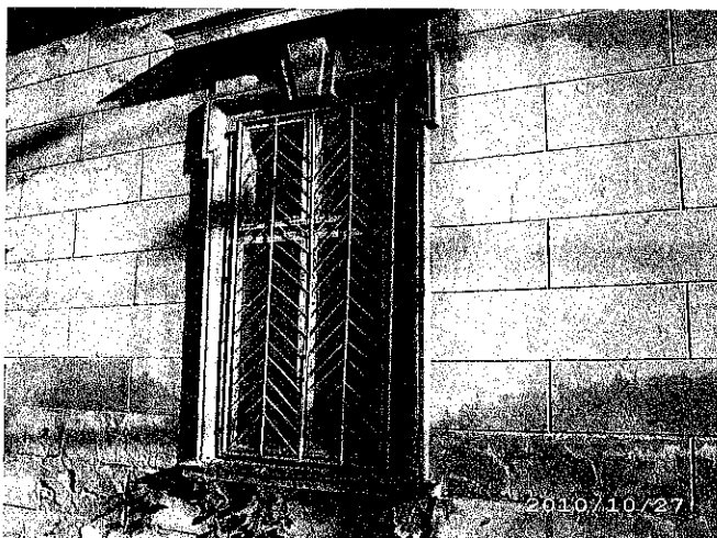
Foto 19 – Sisteme de protecție împotriva efracției la ferestre
