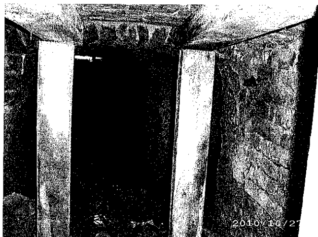
Foto 7 – Intrarea în subsolul clădirii – vedere dinspre curte
