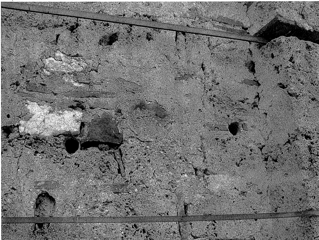
11-12.detalii degradari parament
