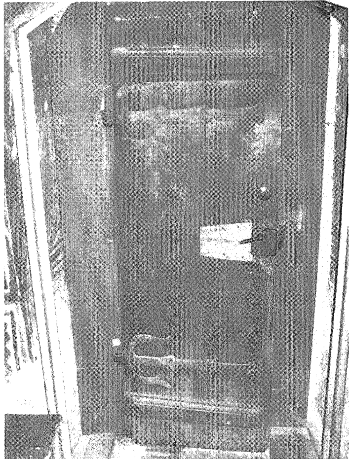
18.usa acces - vedere din pronaos
