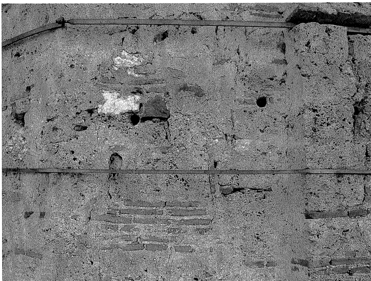
11-12.detalii degradari parament
