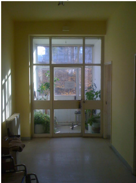
Acces secundar exterior
