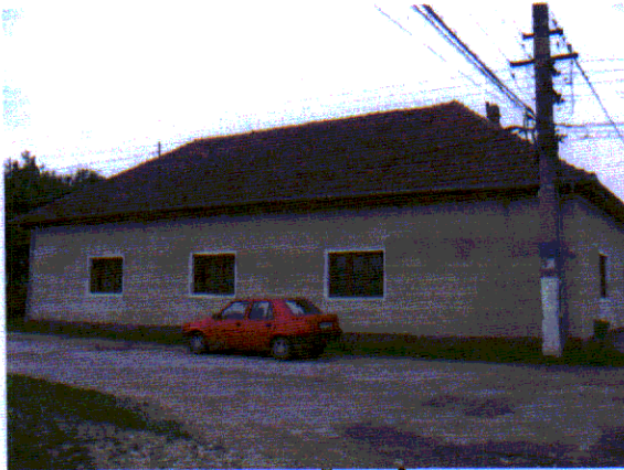
FAȚADA LATERALĂ STÂNGA
