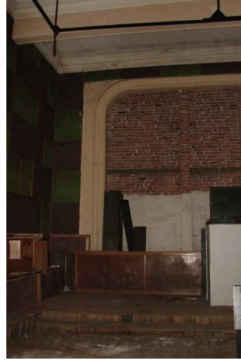
Degradări în fosta sala de cinema
