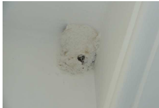
Infiltrații ale apei la etaj
