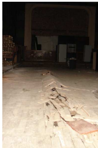
Degradări ale pardoselii din parchet
