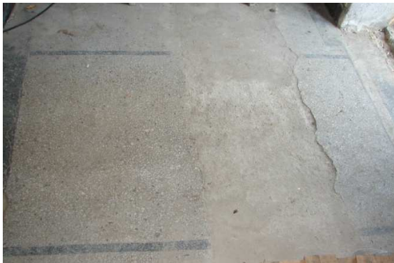
Fisuri în pardoseala din ciment
