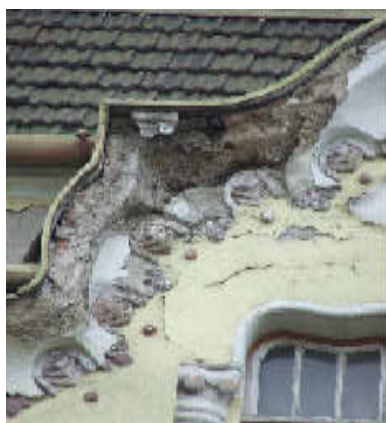
Degradări paretale ale tencuieli și degradări ale elementelor decorative
