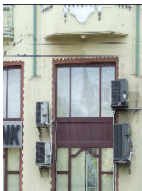
Degradări paretale ale tencuieli și degradări ale elementelor decorative
