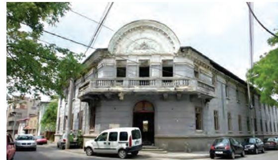
Azilul israelit - 2011. Clădire de patrimoniu aflată în stare avansată de degradare
