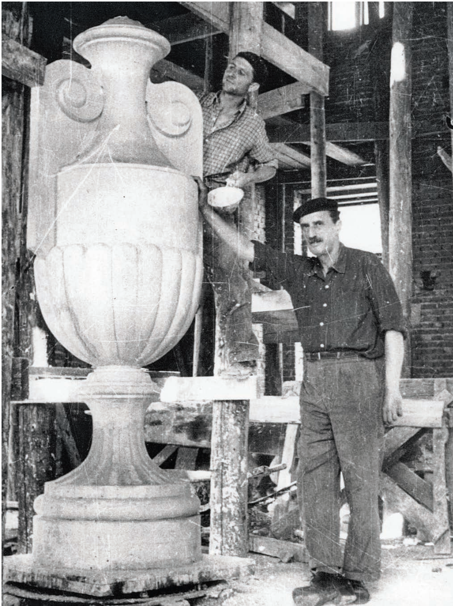
G.M. Cantacuzino, șantier lași, 1958 (?), colecția arh. Șerban Cantacuzino
