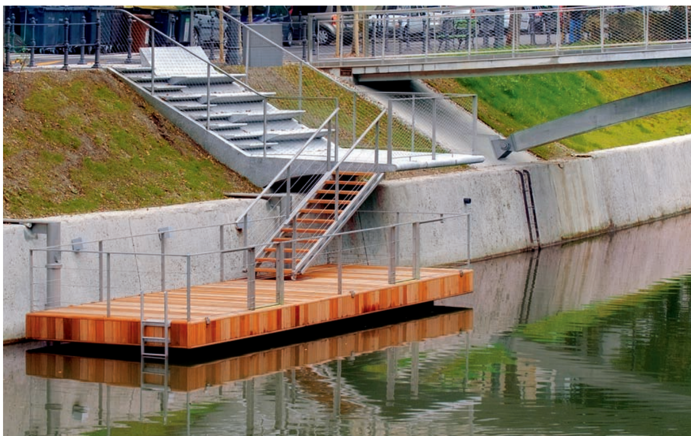
Renovarea malurilor râului Ljubljanica, Ljubljana, Slovenia, 2011. Proiect câștigător al European Prize for Urban Public Space 2012
