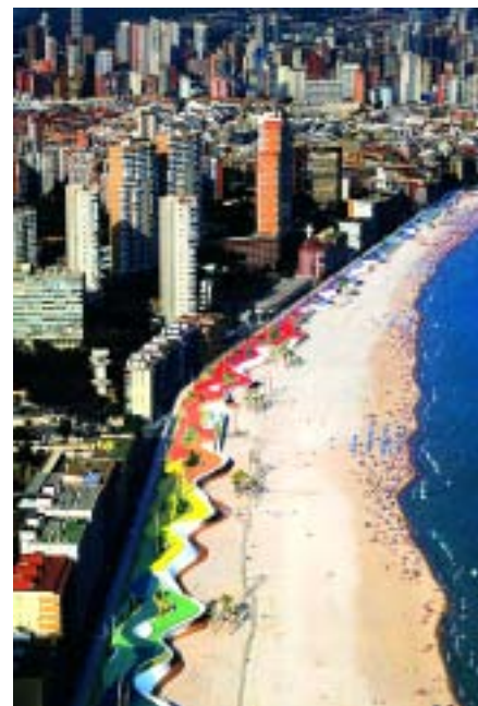
Paseo Marítimo de la Playa Poniente”, Benidorm, Spania (Office of Architecture in Barcelona)
