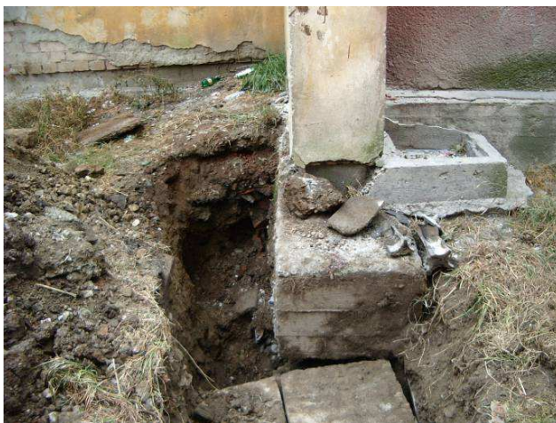
Grinda de fundare la sala cazanelor, S3
