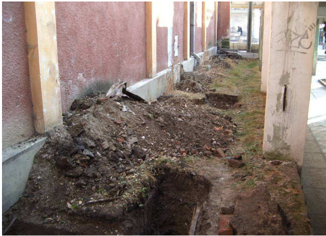
Dezvelirea fundațiilor izolate
