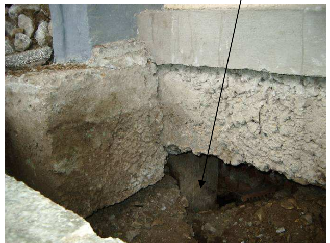
Sistemul de grinzi și un stâlp din zona intrării principale S4
