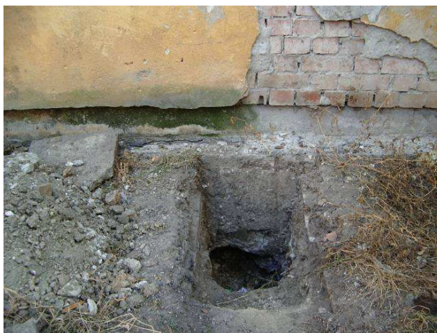
Grinda de fundare la sala cazanelor, S3
