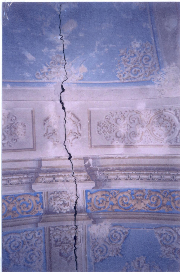
FISURA LONGITUDINALĂ ÎN CHEIA DE BOLTA A BISERICII
