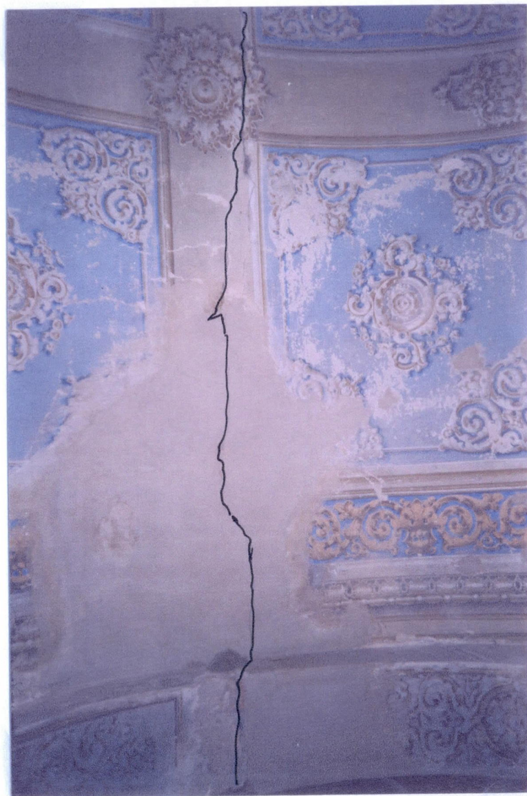
FISURA IN CHEIE BOLTA BISERICA.
